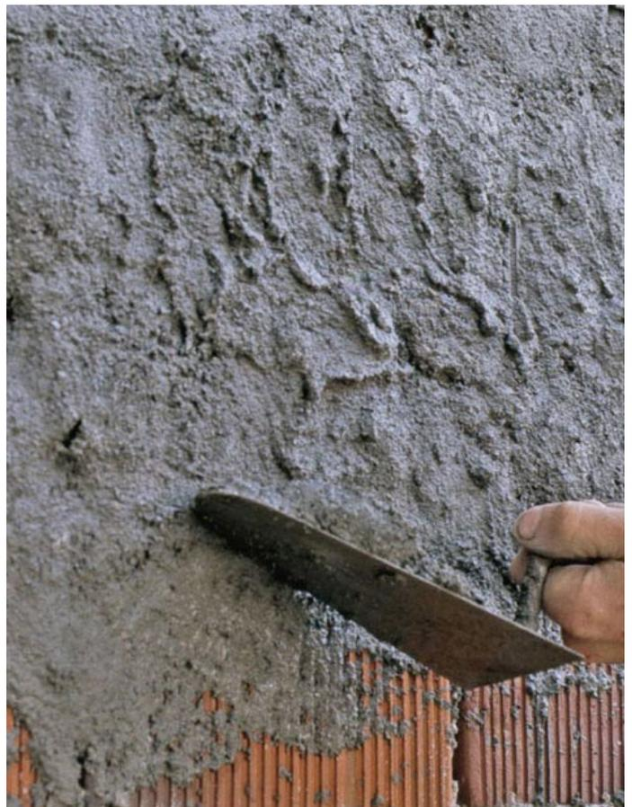
**Figura 16** Applicazione dell'intonaco
