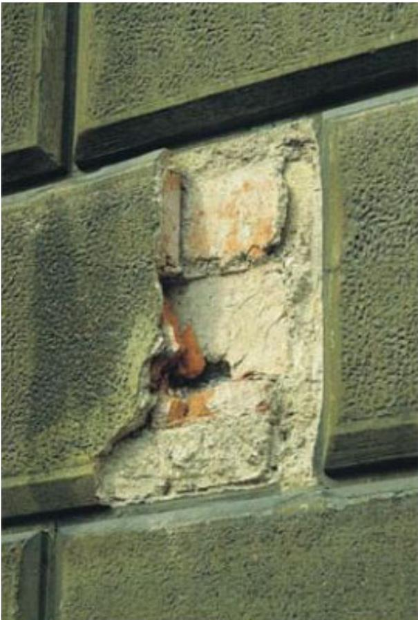
**Figura 15** Ossatura in laterizio sotto un bozzato
