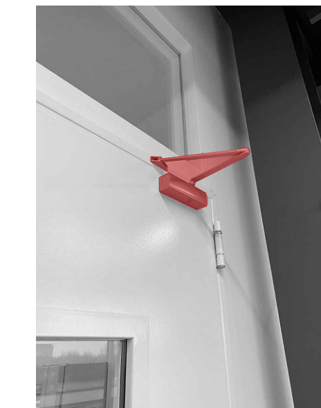
FOTO 2: Sistema a molla chiudiporta automatico
