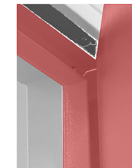
FOTO 3: Battuta cava con guarnizione termospondante
